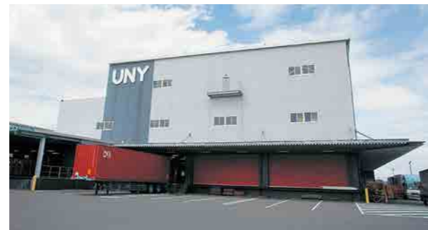
弥富物流センター内のリサイクルセンター
