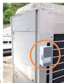
空調室外機に省エネ機器を設置することにより、空調機を最適な運転に遠隔制御
