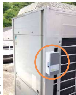
空調室外機に省エネ機器を設置することにより、空調機を最適な運転に遠隔制御
